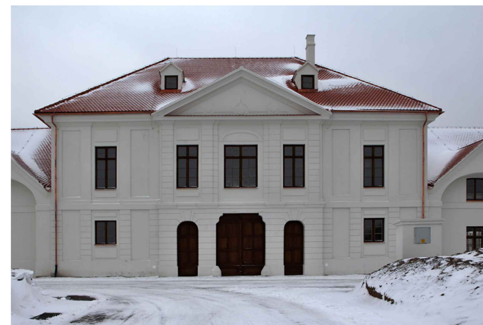
Vonkajší pohľad na kaštieľ
